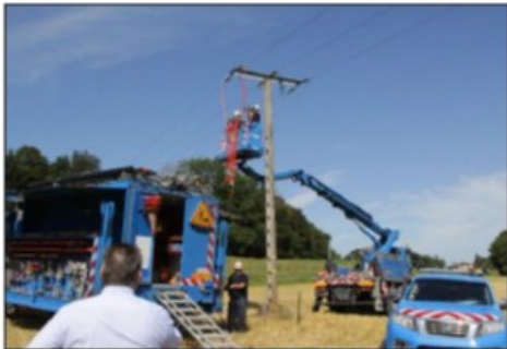
Un important dispositif est déployé par Enedis pour installer 19 protections avifaunes sur sept poteaux. Photo L'Aisace
