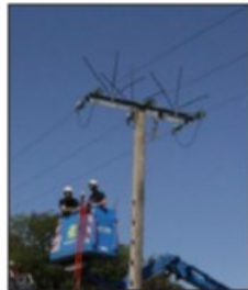
Le travail des techniciens demande une synchronisation parfaite. À 11 h 45, le dispositif était installé. Photo L'Aisace
